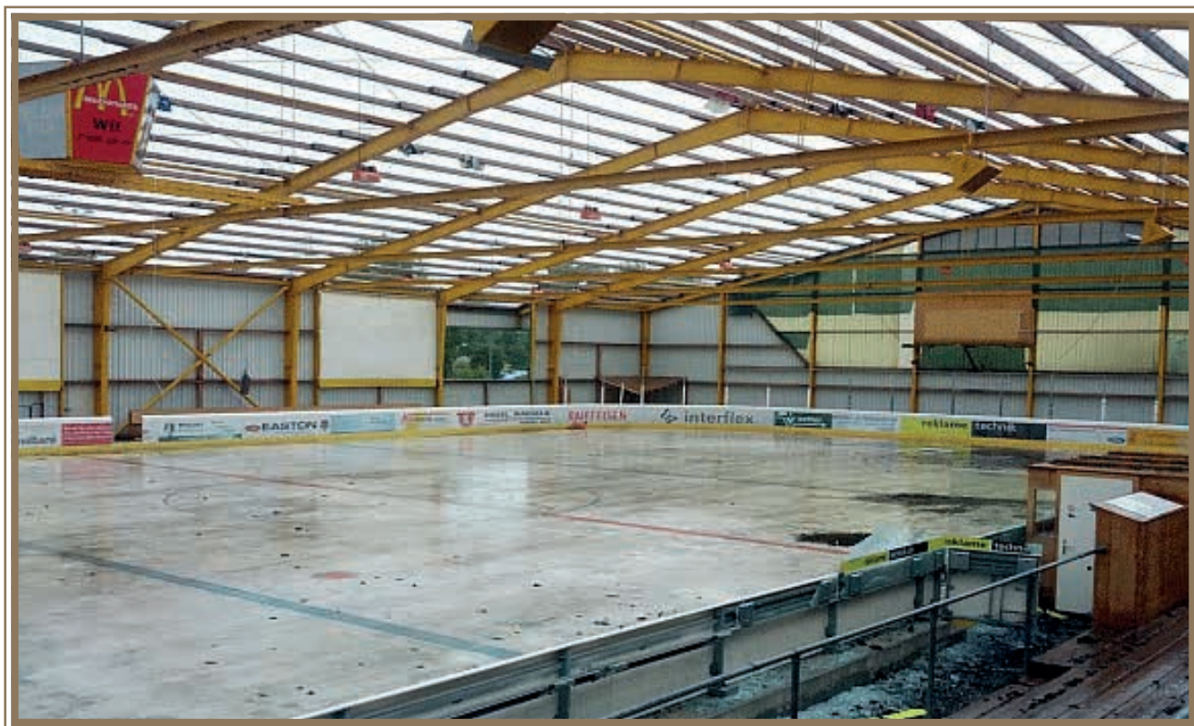
alte Eishalle kurz vor dem Abbruch
